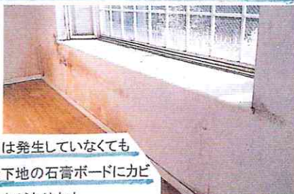
掃出し窓と通気口が近くにあるクロスのカビ
