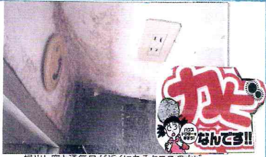
掃出し窓と通気口が近くにあるクロスのカビ
