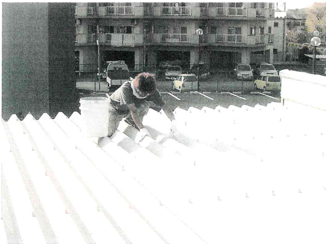
有限会社鳥羽製作所 塗る断熱材施工中
