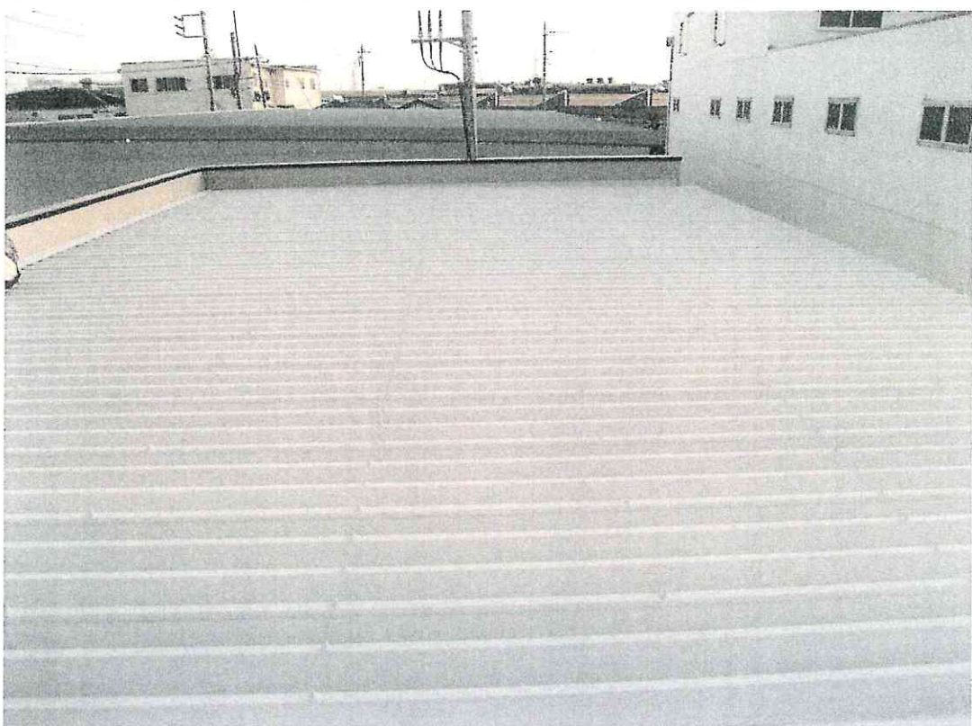
有限会社鳥羽製作所 塗る断熱材完成写真
