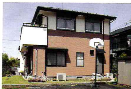
O邸：塗布箇所／屋根：90.9㎡、外壁：156.95㎡。
